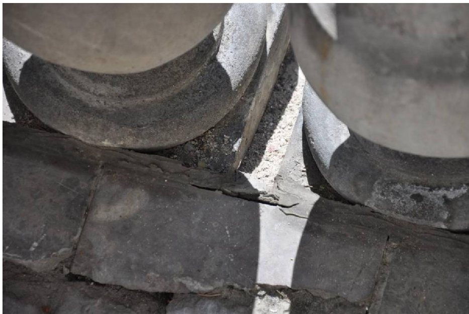
Widok na taras z widocznymi spękaniami posadzki
