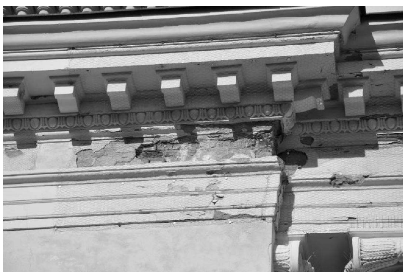
Uszkodzenia spowodowane przez nieszczelną rurę spustową, elewacja 26-27
