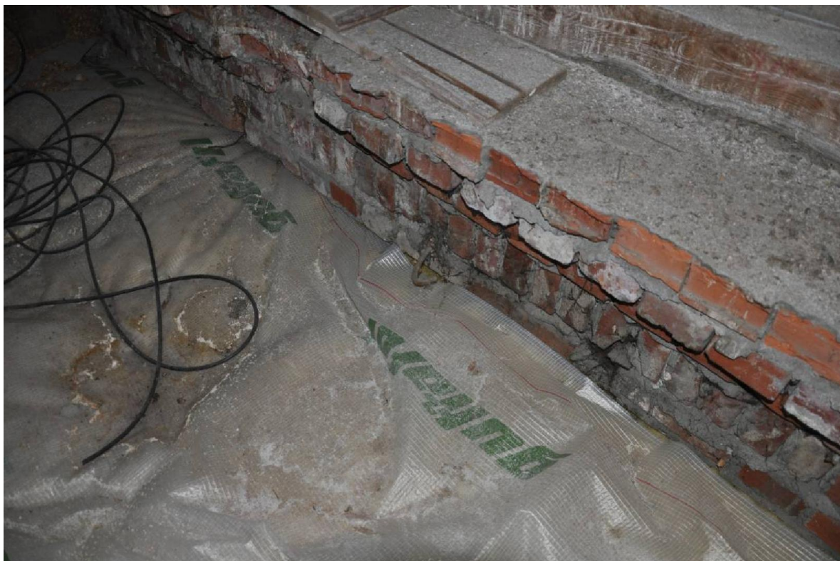
Wygląd gzymsów bez sztukaterii (widoczne kotwy do mocowania sztukaterii)
