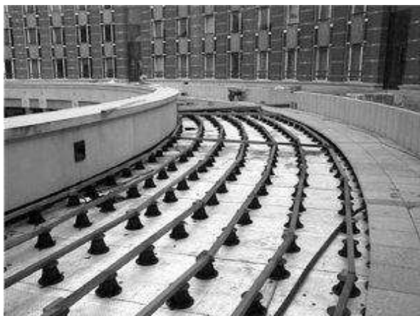
Przykład układania podłogi technicznej na tarasie, wykończenie z płytek.
