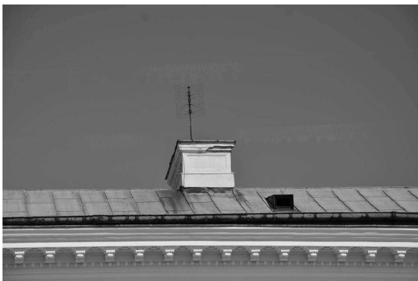
Komin z rozwarstwieniami i ubytkami tynków.
