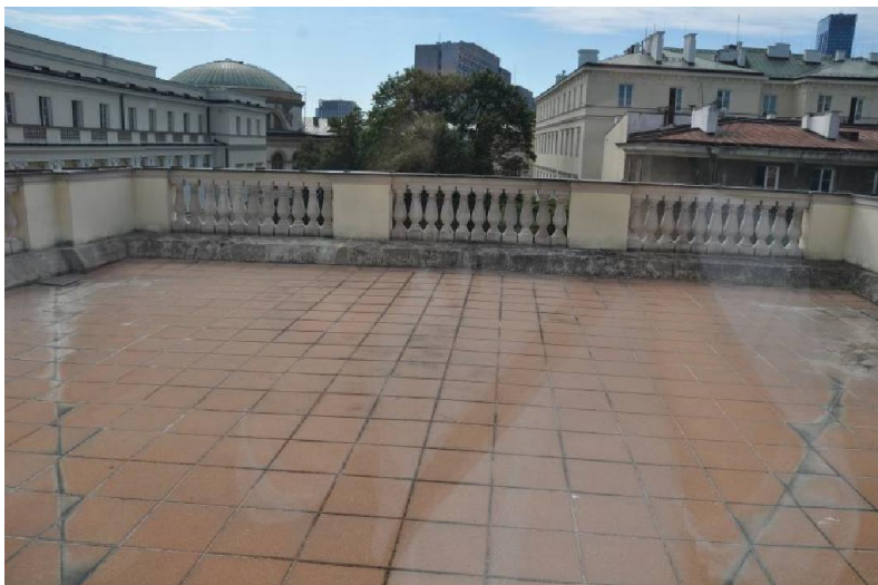
Widok na taras z widocznymi spadkami w kierunku wpustów tarasowych.
