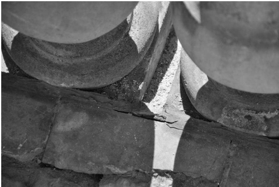
Widok na taras z widocznymi spękaniami posadzki
