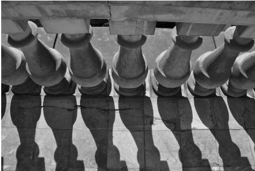
Widok na taras z widocznymi spękaniami posadzki
