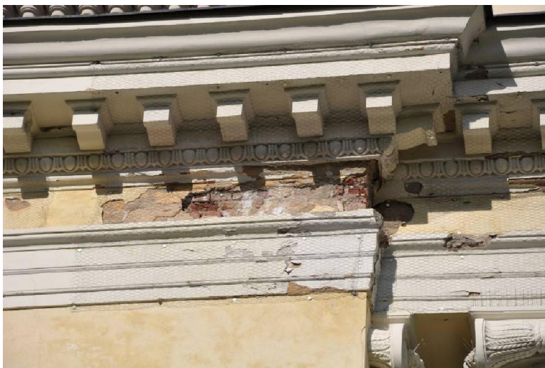
Uszkodzenia spowodowane przez nieszczelną rurę spustową, elewacja 26-27
