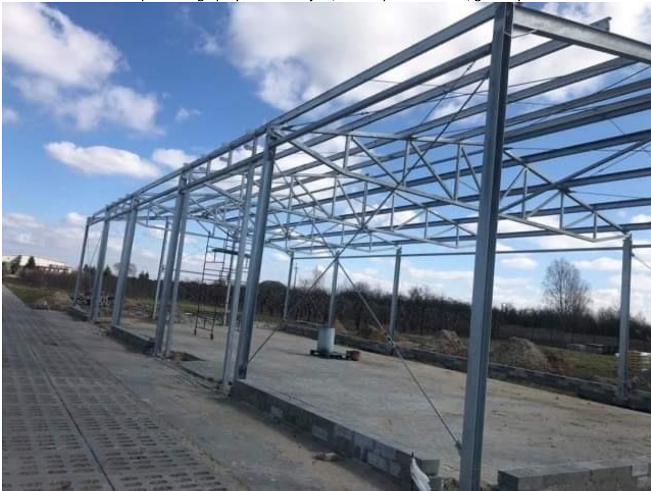
Konstrukcja stalowa hali oraz ścianka do rozbiórki.
