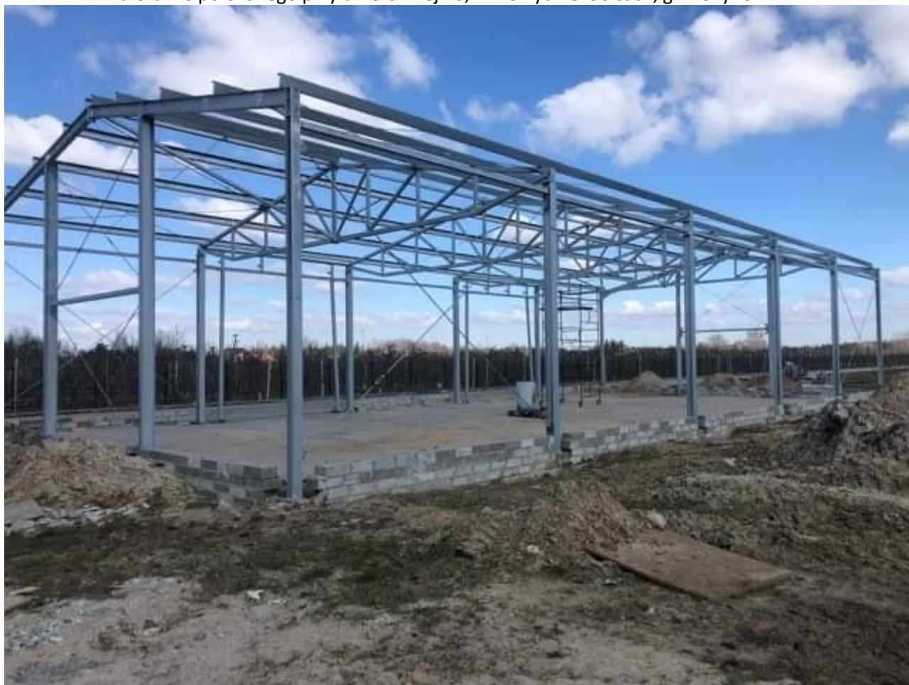
Konstrukcja stalowa hali oraz ścianka do rozbiórki.
