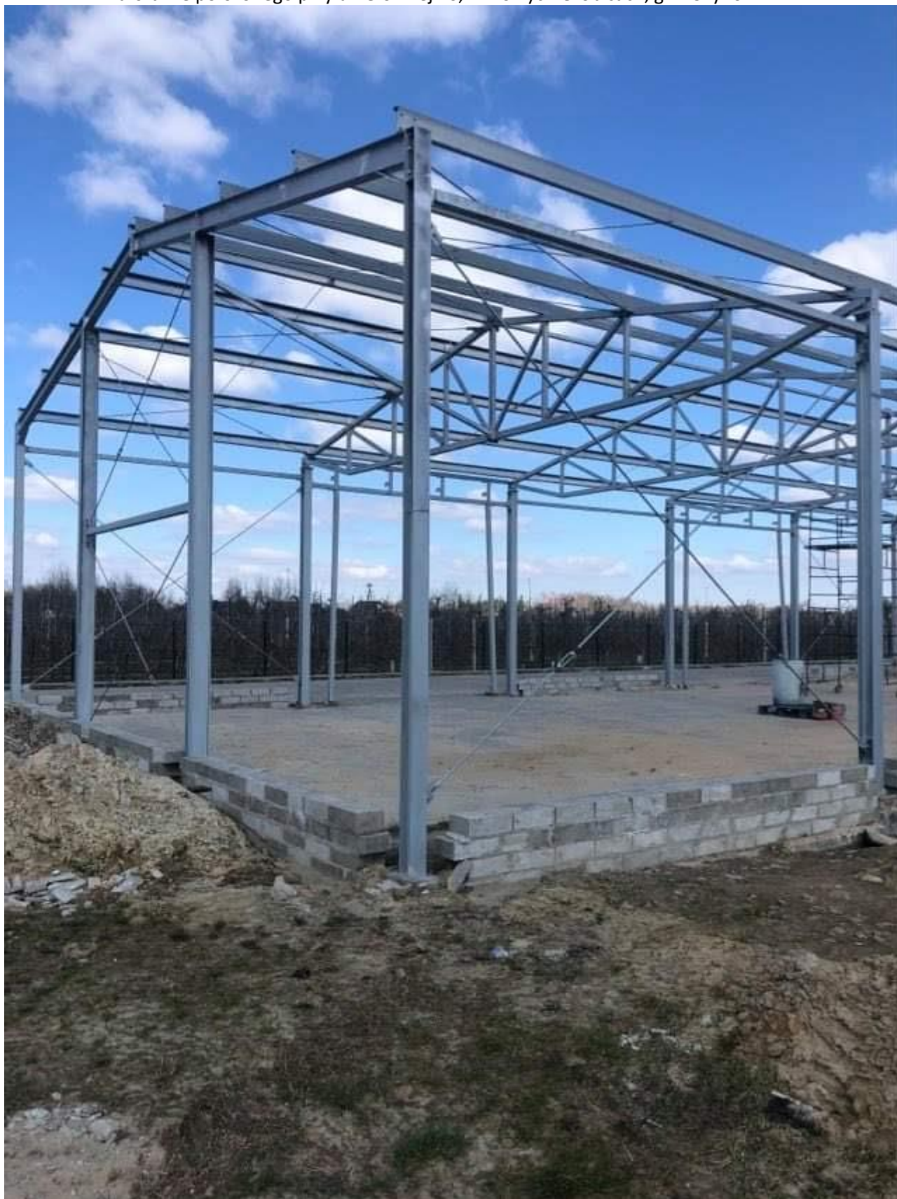
Konstrukcja stalowa hali oraz ścianka do rozbiórki
