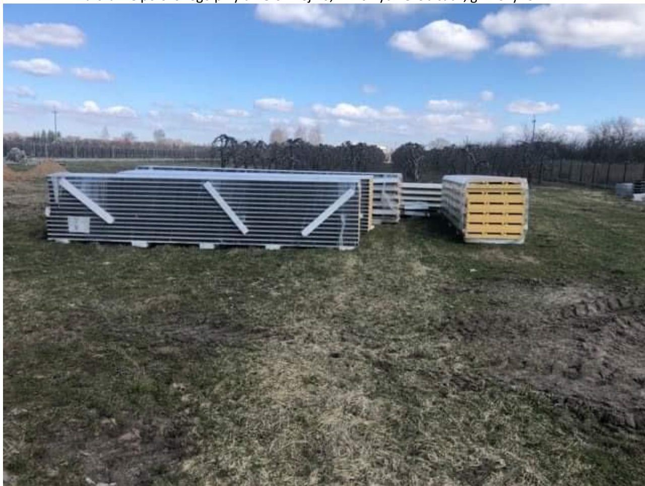
Konstrukcja stalowa hali oraz ścianka do rozbiórki
