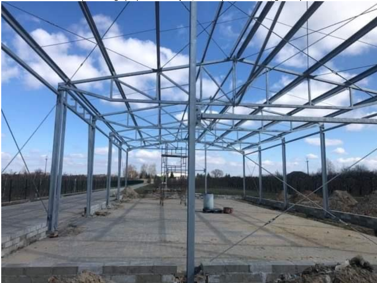
Konstrukcja stalowa hali oraz ścianka do rozbiórki.
