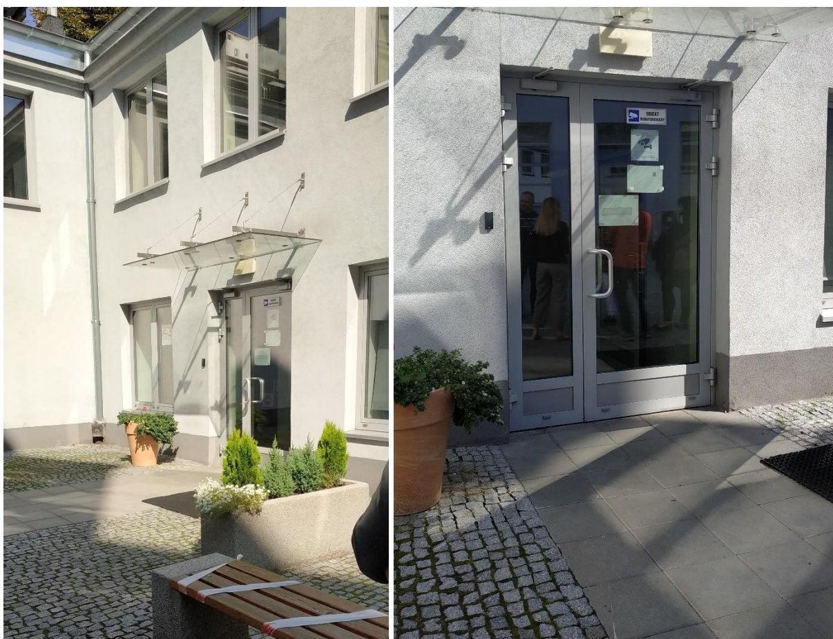
Rys. 2 Drzwi wejściowe z dziedzińca – montaż siłowników, kamery i domofonu na słupku na odpowiedniej wysokości (dostosowanej do potrzeb osób poruszających się na wózkach inwalidzkich)
