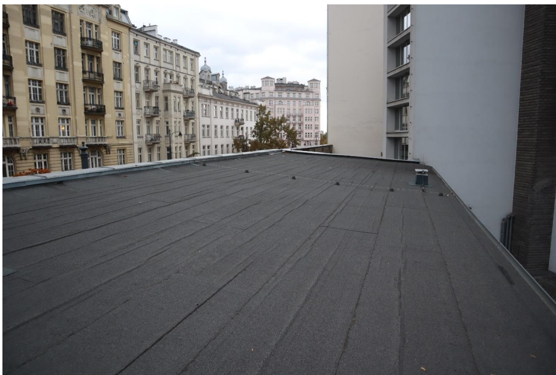
Fot. 5. Dach od strony Placu Unii Lubelskiej
